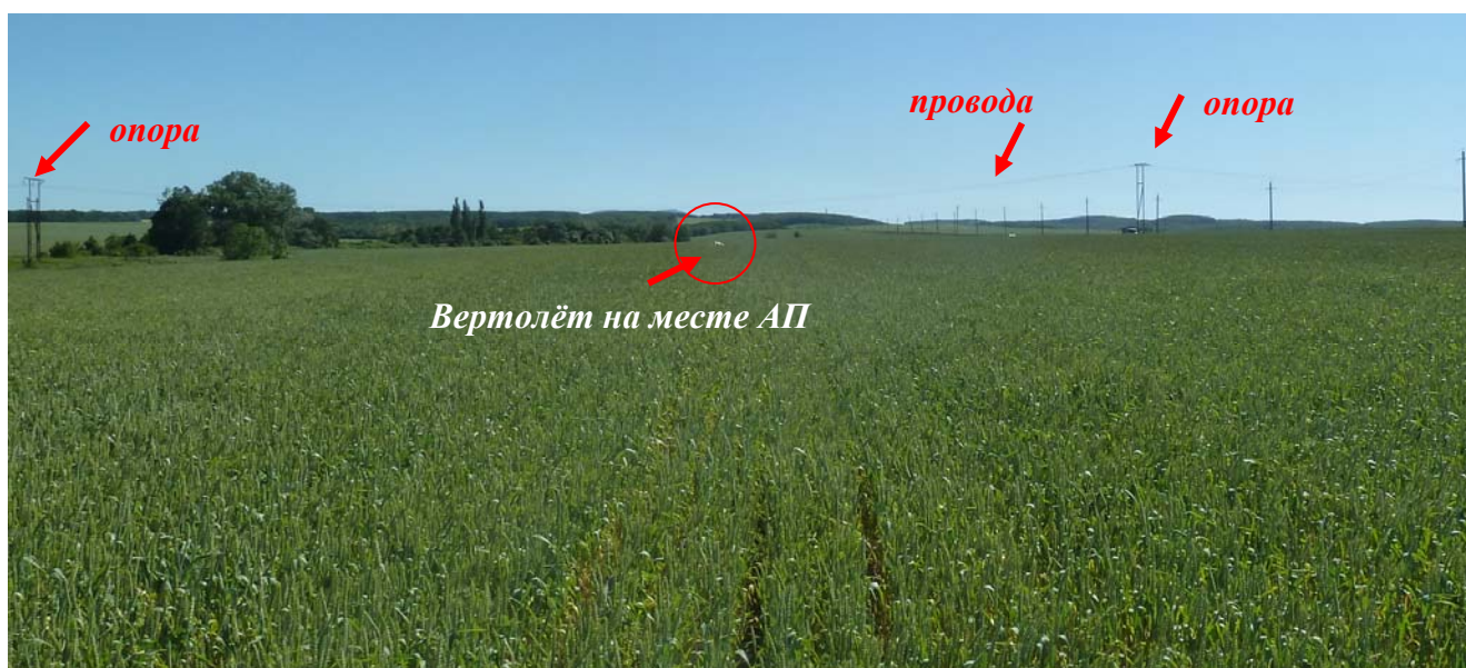
Рис.3. Опоры стоят по краям участка, а провода сливаются с линией горизонта.
